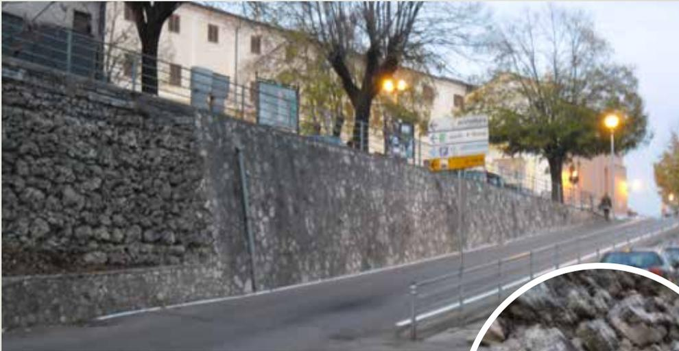
Sequenza fotografica relativa ai muri di contenimento, con particolari della cortina in mattoni e relativo esempio della costruita bocchetta di scolo e un particolare della cortina muraria sulla rampa di accesso alla Chiesa di San Gerardo, realizzata a pietre calcaree del tipo nostrano chiamato "tartara" in posa grezza.
