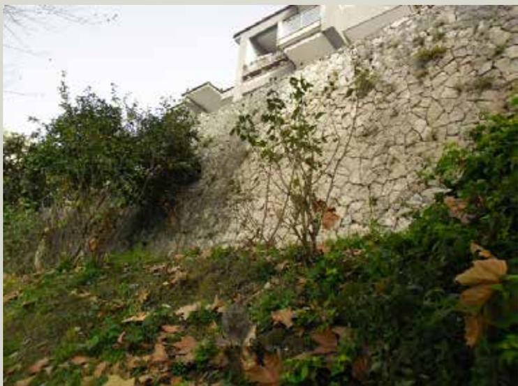
Il muro termina sullo spigolo di contrafforte, costruito da grosse pietre d'angolo, che prosegue raccogliendosi profondamente all'interno e curvando sul secondo terrapieno.
