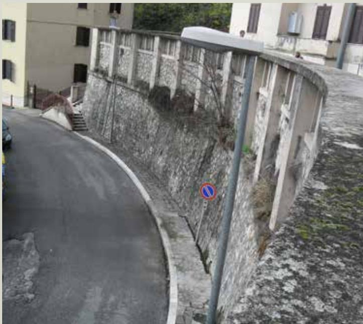
conflitto mondiale, ha previsto un complesso di muraglioni di contenimento per la realizzazione di una rampa stradale di accesso, costruito con pietre di calcare stuccate a rilievo, che sfrutta in alcuni punti i banchi di roccia di arenaria.
