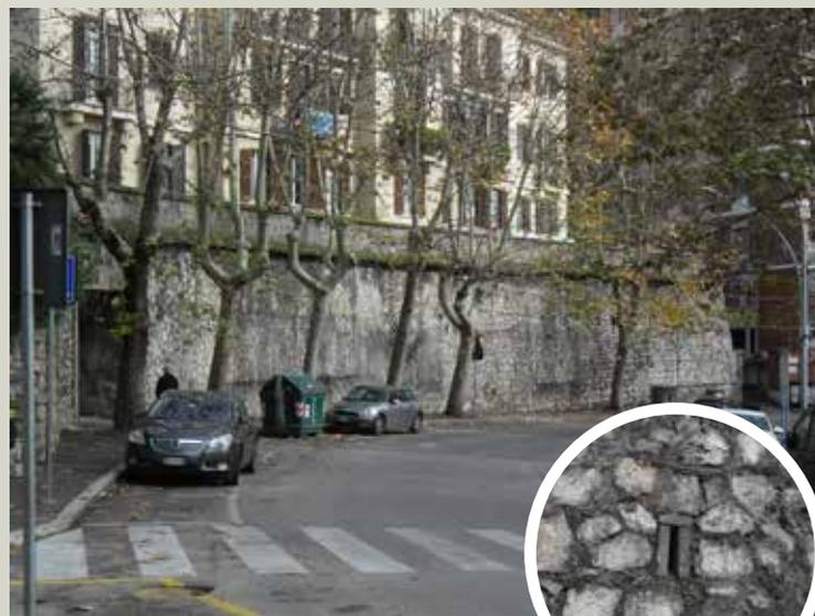
Tratto della seconda struttura muraria lungo il Viale, sempre sostegno del complesso edilizio costruito sul piano rialzato della collina, e un particolare della bocca di scolo ricavata nella cortina muraria e formata da mattoni.
