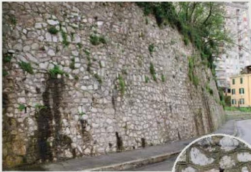
Primo grande tratto murario relativo alla costruzione dei muri di contenimento lungo tutto il percorso della Via delle Fosse Ardeatine per il contenimento dei dirupi. Particolare della bocca di scolo.
