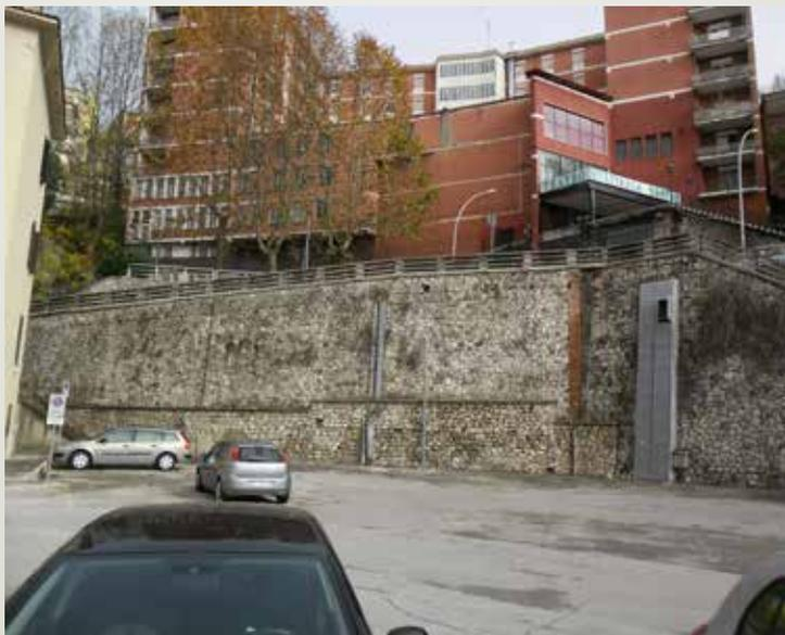
Due foto delle strutture murarie di rinforzo e contenimento a favore del complesso edilizio ricavato nella depressione dei piani stradali. Il parapetto del muro più basso è costituito da elementi legati in calcestruzzo armato a costole verticali aperte.
